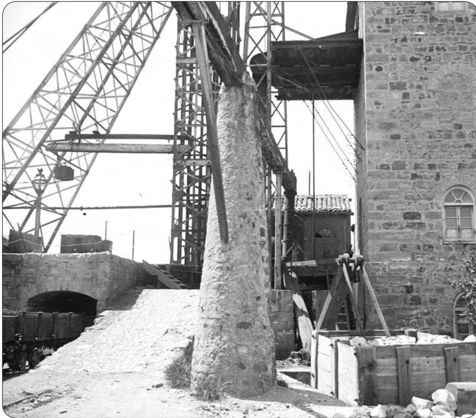
Fig. 7: Castillete y bomba de desagüe de balancín en la mina Arrayanes.
