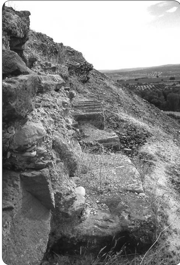
Fig. 6.- Un fragmento de cornisa usado como material de construcción en las reformas de la muralla.
