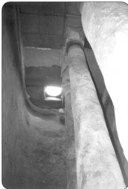
Fig. 9.- Interior de uno de los aljibes, excavado en el año 2000
